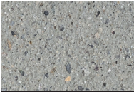
RC-Betonplatte leicht gestrahlt
